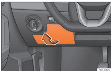
Abb. 160 Auf der Fahrerseite in der Instrumententafel: Abdeckung des Sicherungskastens.
